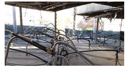
현장 열탈착 (In Situ thermal desorption)
