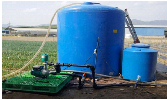
[그림 III-17] 자동 점적 관수 시스템 설치
